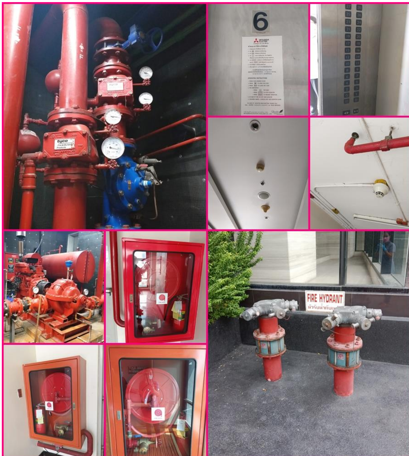
รูปที่ 1.47 ระบบป้องกันอัคคีภัยของโครงการ ประกอบด้วย ระบบท่อน้ำดับเพลิงภายนอก อาคาร เก็บสายฉีดน้ำดับเพลิงพร้อมอุปกรณ์ ระบบดับเพลิงอัตโนมัติ และลิฟต์ดับเพลิง
